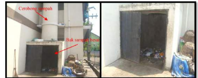
Gambar 5.27 Foto Cerobong/Shaft Sampah Rusunawa Pesapen
